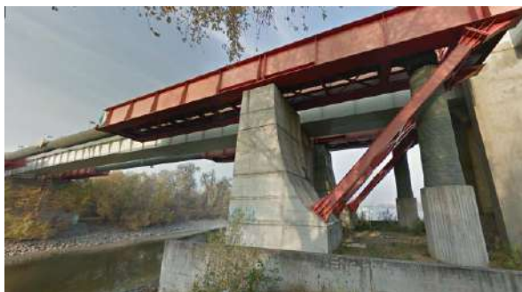
Nyomócsőpár gyalogoshídon történő átvezetése (forrás: maps.google.com)
