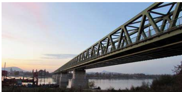
Újpesti vasúti híd
