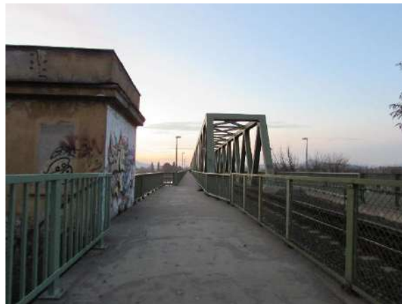
Újpesti vasúti híd
