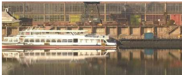
Rossz műszaki állapotú támfalak
